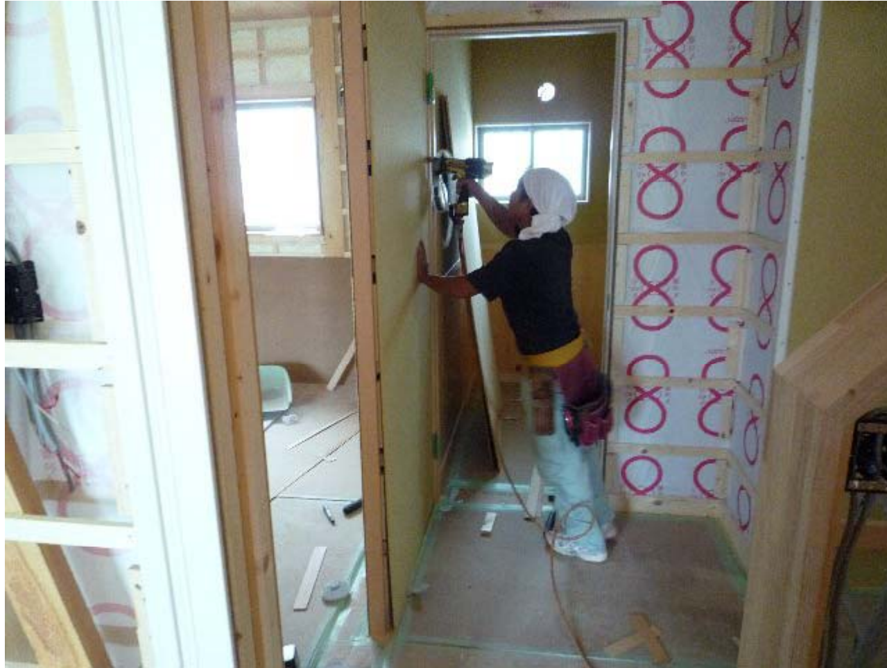
便所入口・廊下
